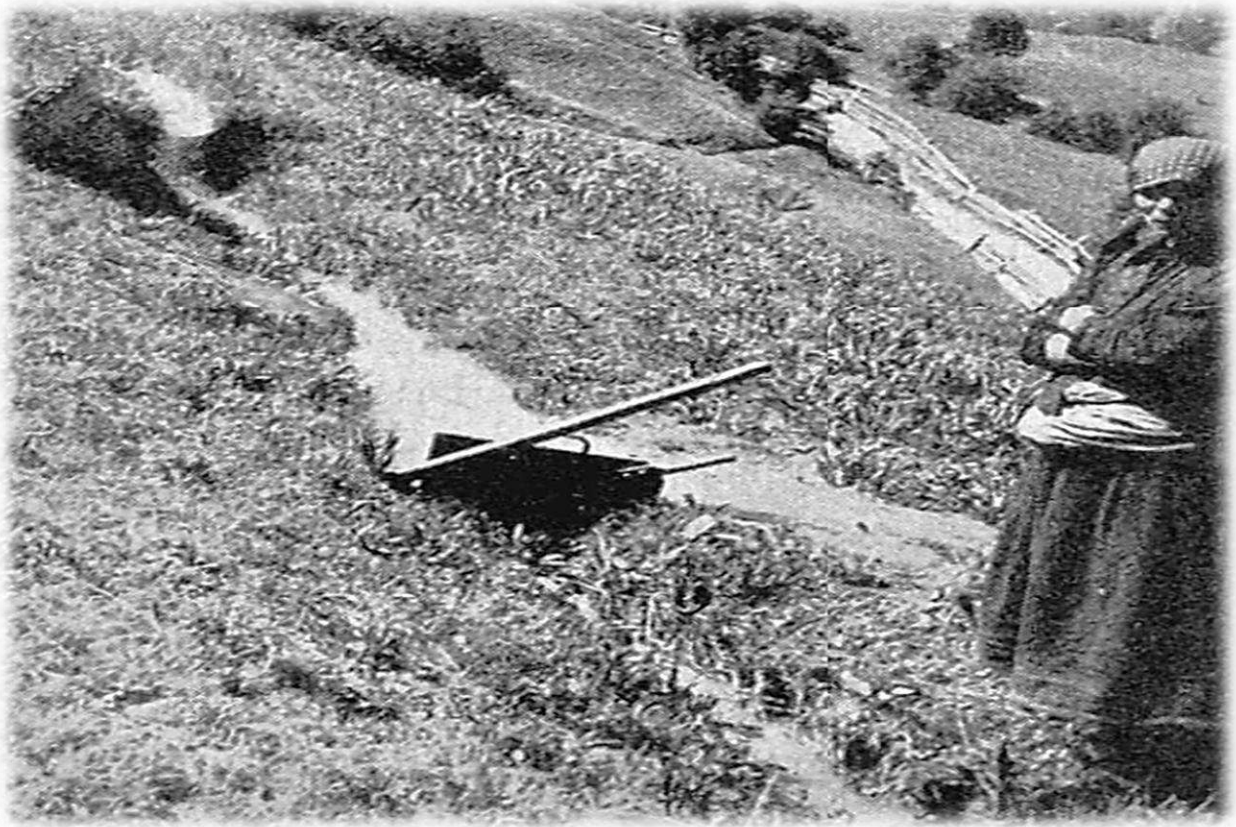
Abb. 4. In der aus dem Turtmantal kommenden Suone von Ergisch hat die Wächterin das Wasserbrett eingeschlagen und damit das Wasser auf die Wiese rechts abgeleitet. Photo: R. PFISTER.
