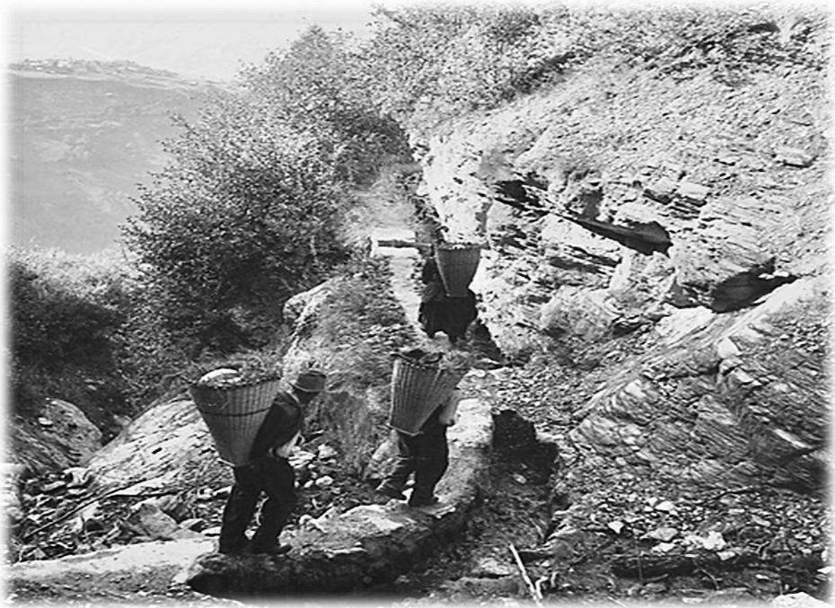
Auf der Ärgischer Wasserleitu
