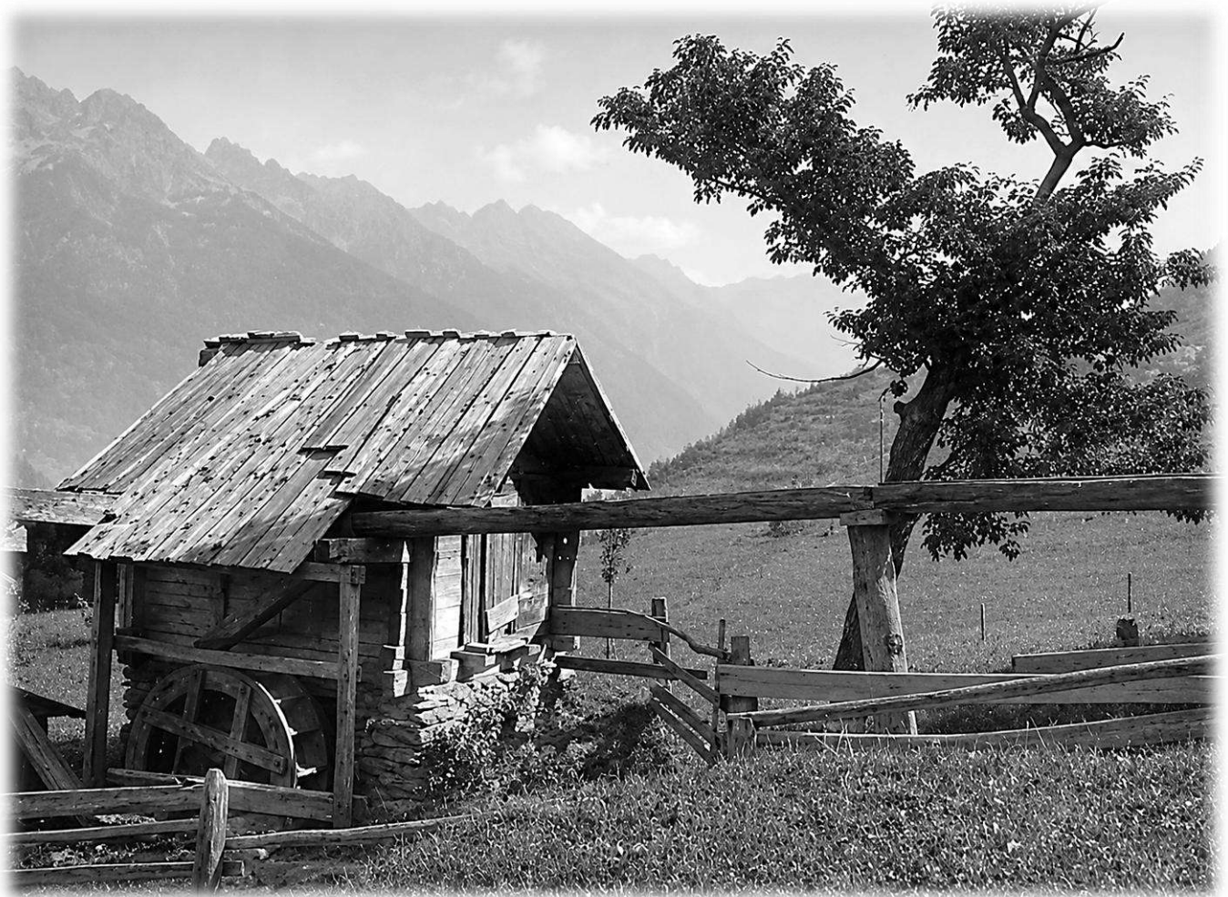
Wasserzufuhr zur alten Mühle in Unterems. Foto v. 1928. Privatsammlung JP Meyer
