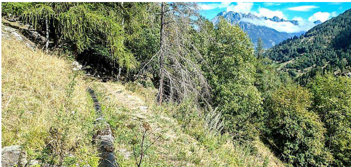
Wasserleitu Oberi Leiggeru (in Rohrleitung)
