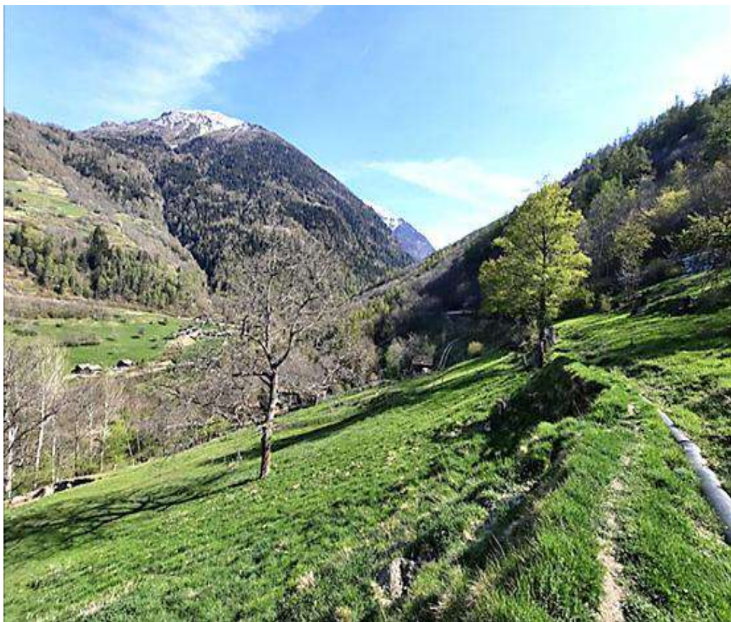
Die Wasserleitung bei Fätsch
