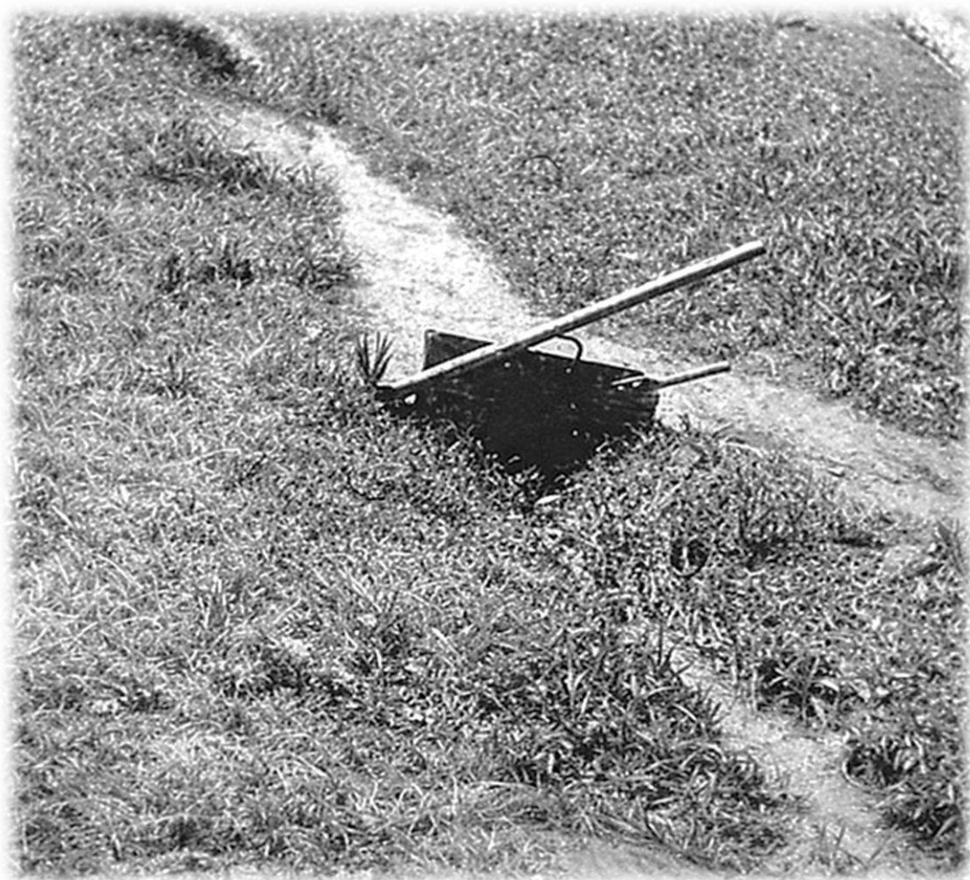
Abb. 4. In der aus dem Turtmantal kommenden Suone von Ergisch hat die Wächterin das Wasserbrett cingeschlagen und damit das Wasser auf die Wiese rechts abgeleitet. Photo: R. PFISTER.
