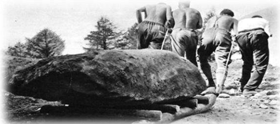
Bau einer Strasse in Ergisch
