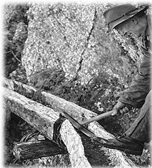
«Toggenloch, Toggen und Kännel» in der Wasserleitu Blyschí. In: Schweizer Illustrierte 1957
