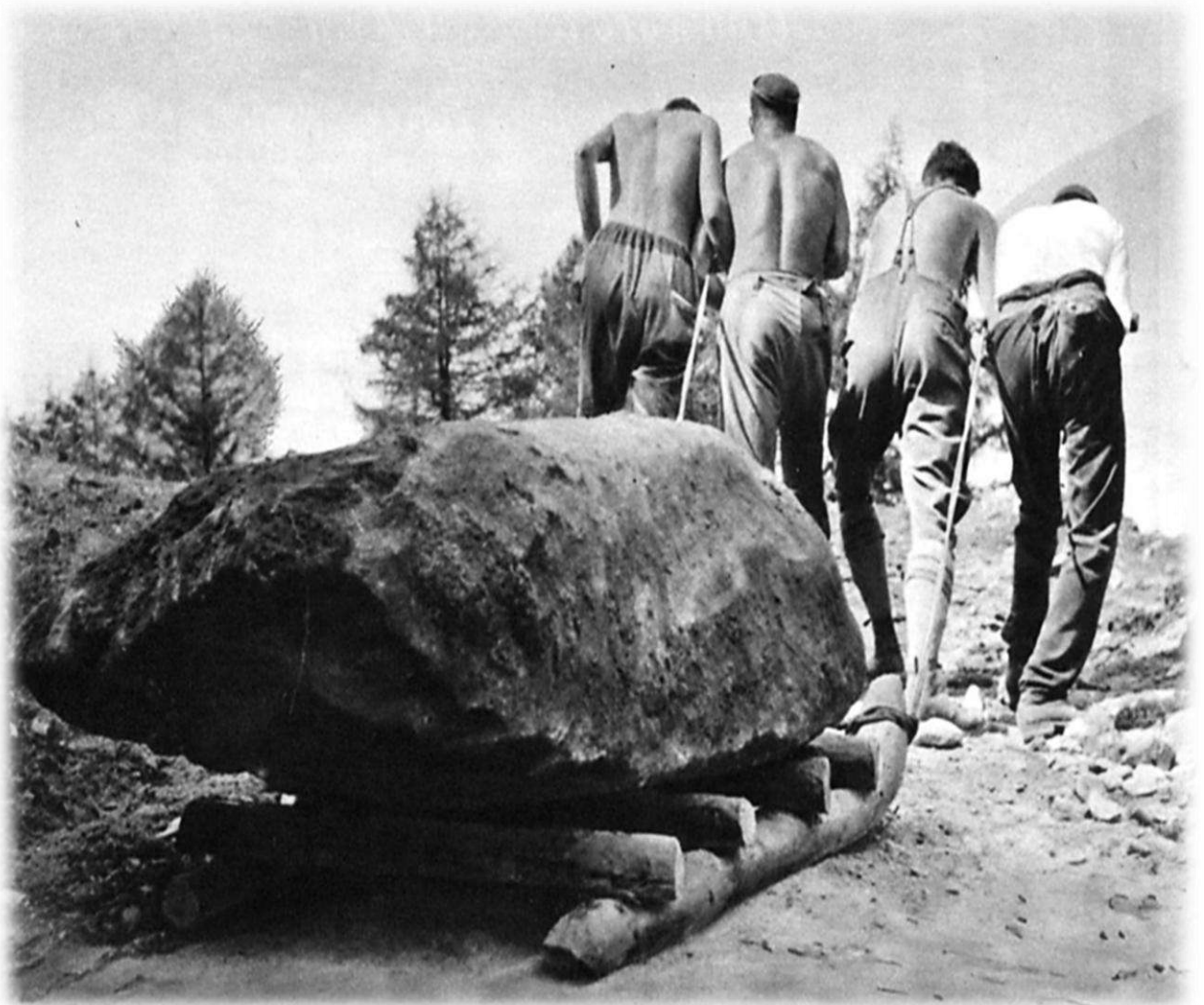
Keine leichte Arbeit, der Transport eines 1000 Kilogramm schweren Steins mit dem Holzschlitten. Mancher Schweißtropfen trinkt den Weg. (Spezialaufnahme von E. Steimle, Zürich.)
