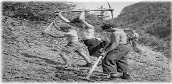
Bau eines Alpwegs
