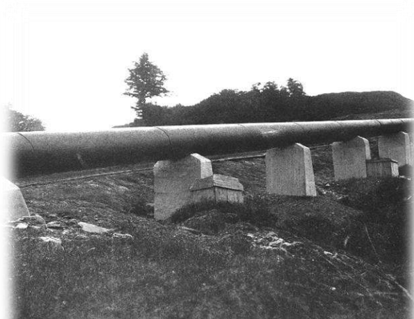
Abb. 11. Illsee-Turtmann. Druckleitung Oberems-Turtmann. Rohrpartie auf Sockeln.
