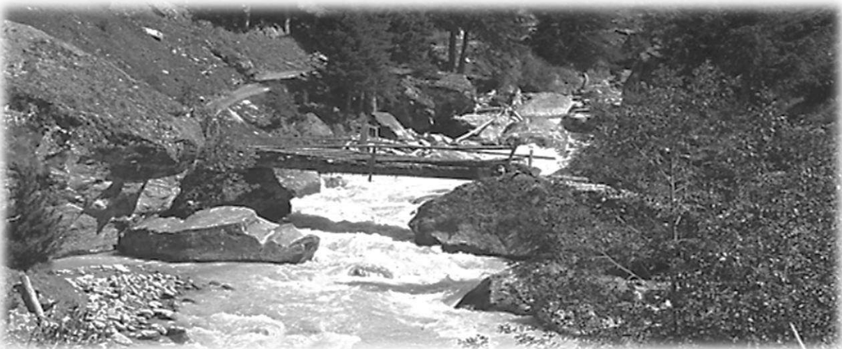
Blick taleinwärts auf Brücke im Vollensteg. Fotograf unbekannt, um 1920-30
