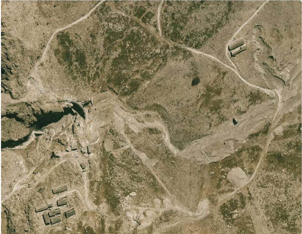
Staubbecken und Baubaracken. Eidgenössische Flugplatzdirektion, 4. Juni 1959
