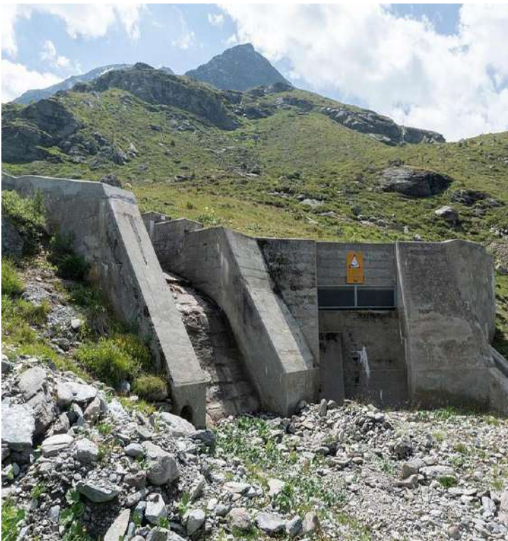
Wasserfassung und -zufuhr vom Brändjítelli zum Stausee. Sommer 2025
