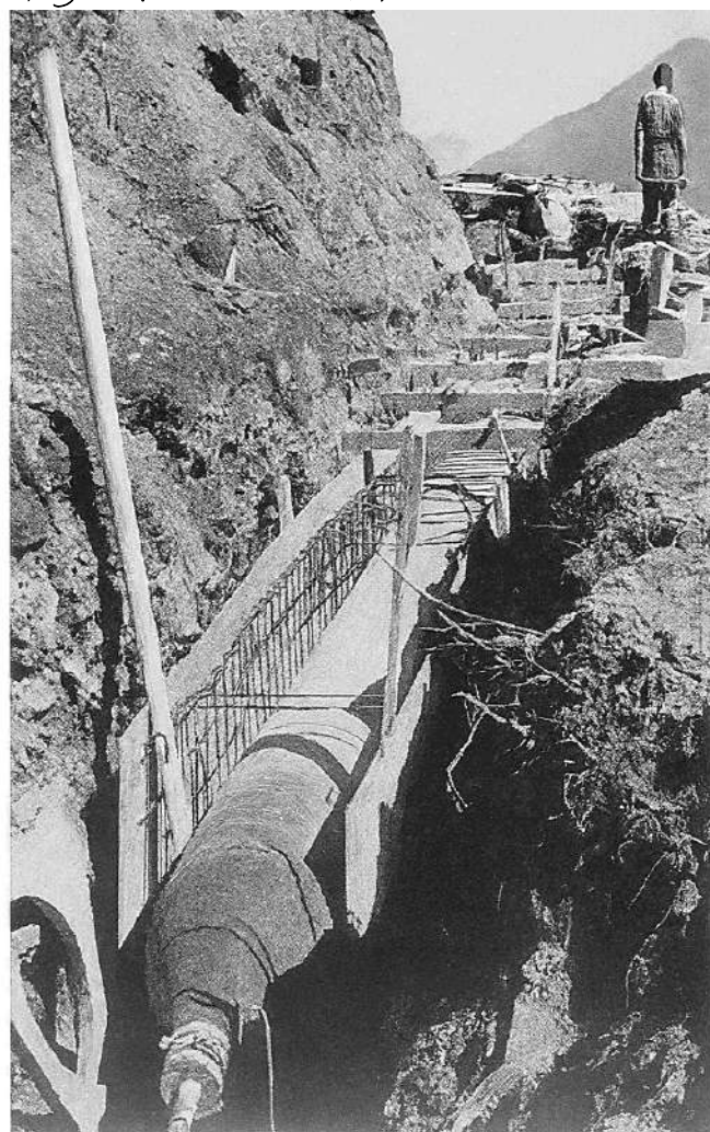
Fig. 12. Conduite à flanc de coteau de Blumatt, coffrage «Ductube» ø 60 cm
