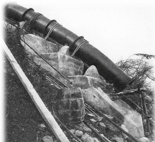
Abb. 10. Illsee-Turtmann. Druckleitung Oberems-Turtmann. Fixpunkt-Rohr VI verlegt.
