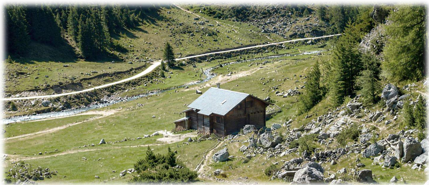
Wasserleitung vom Blumattbach aus, 1961. Privatsammlung JP Meyer
