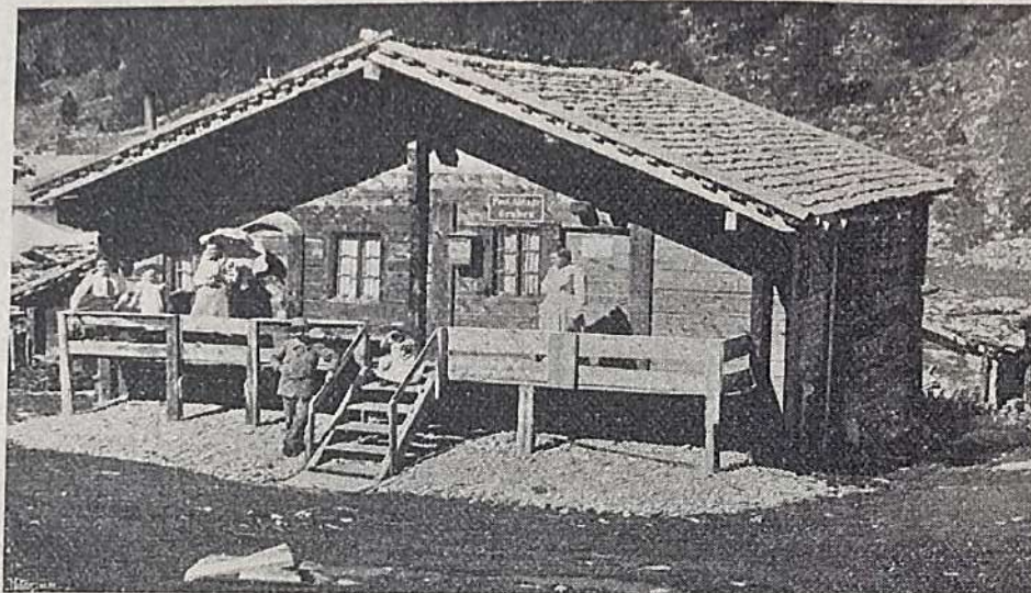
La poste fédérale à Gruben.
