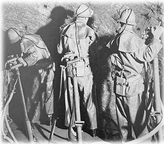
Mineure beim Bohren der Sprenglöcher
