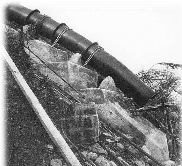
Abb. 10. Illsee-Turtmann. Druckleitung Oberems-Turtmann. Fixpunkt-Rohr VI verlegt.
