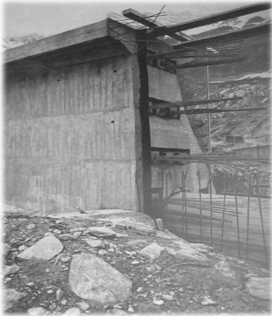
Erstmalige Verwendung von vorgespanntem Beton beim Staumauerbau; Armierungsdetail
