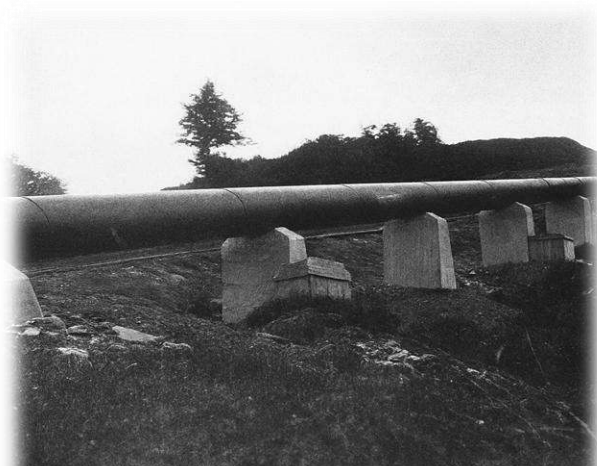
Abb. 11. Illsee-Turtmann. Druckleitung Oberems-Turtmann. Rohrpartie auf Sockeln.
