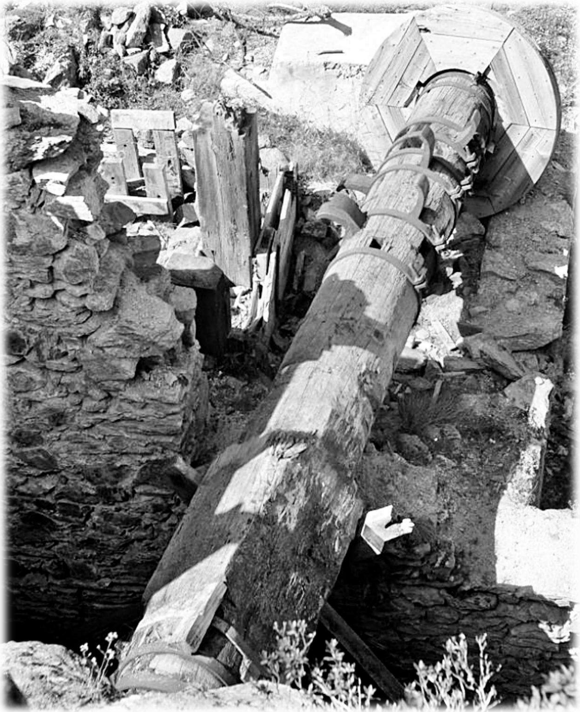
Die mächtige Zapfwelle, welche die 6 Pochstempel antrieb. Foto v. Ernst Brunner um 1940
